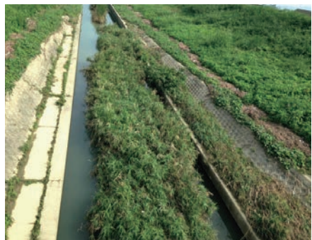
東天川1丁目の中堤橋から下流
