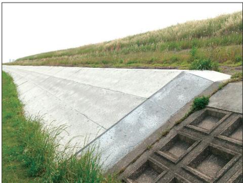
↑亀裂部分をコンクリートで応急処置した堤防
